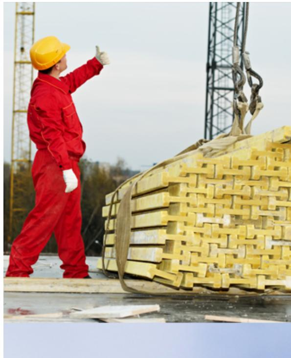
**Controlar y supervisar el movimiento seguro de la grúa durante el izaje:** Esto quiere decir que el Rigger debe determinar las maniobras adecuadas mientras el operador se encuentra operando la máquina de elevación. Para ello debe tener claro los ángulos de izaje y las normas de seguridad para que estas se cumplan.
