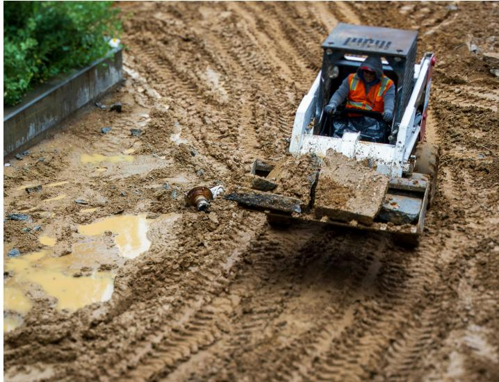
En nuestra faena, sabemos que durante la excavación de pilas es necesario retirar el material extraído mediante el uso de minicargador. Esta interacción entre personas que trabajan al interior de la excavación y equipos en movimiento representa uno de los riesgos más críticos del proceso. Un descuido, una mala coordinación o una distracción puede derivar en un accidente grave o incluso fatal.
