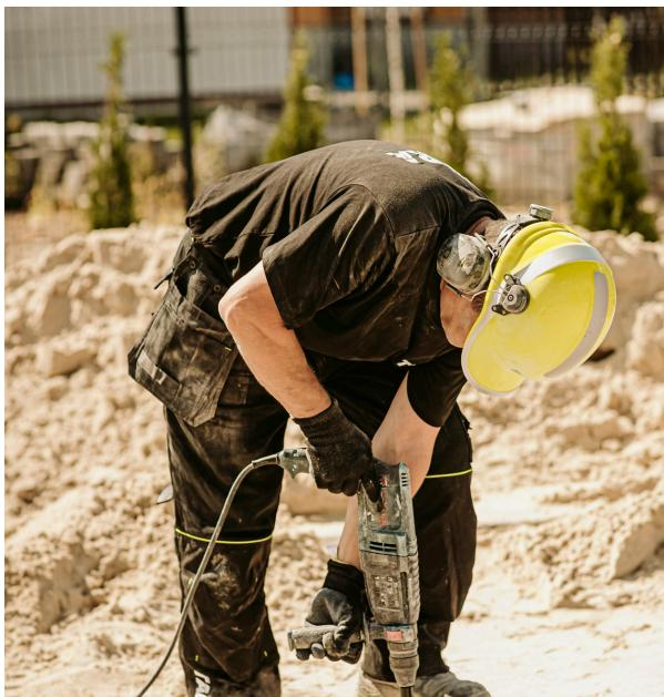
El Kango o martillo demoledor es una herramienta potente y fundamental en faenas de demolición, rompimiento de concreto, excavaciones y otras tareas de obra civil. Sin embargo, su uso inadecuado puede generar riesgos graves para el operador y quienes lo rodean.
